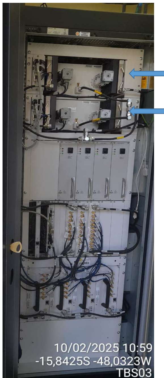
Figura 02: Duas ATC instaladas em uma TB3.
